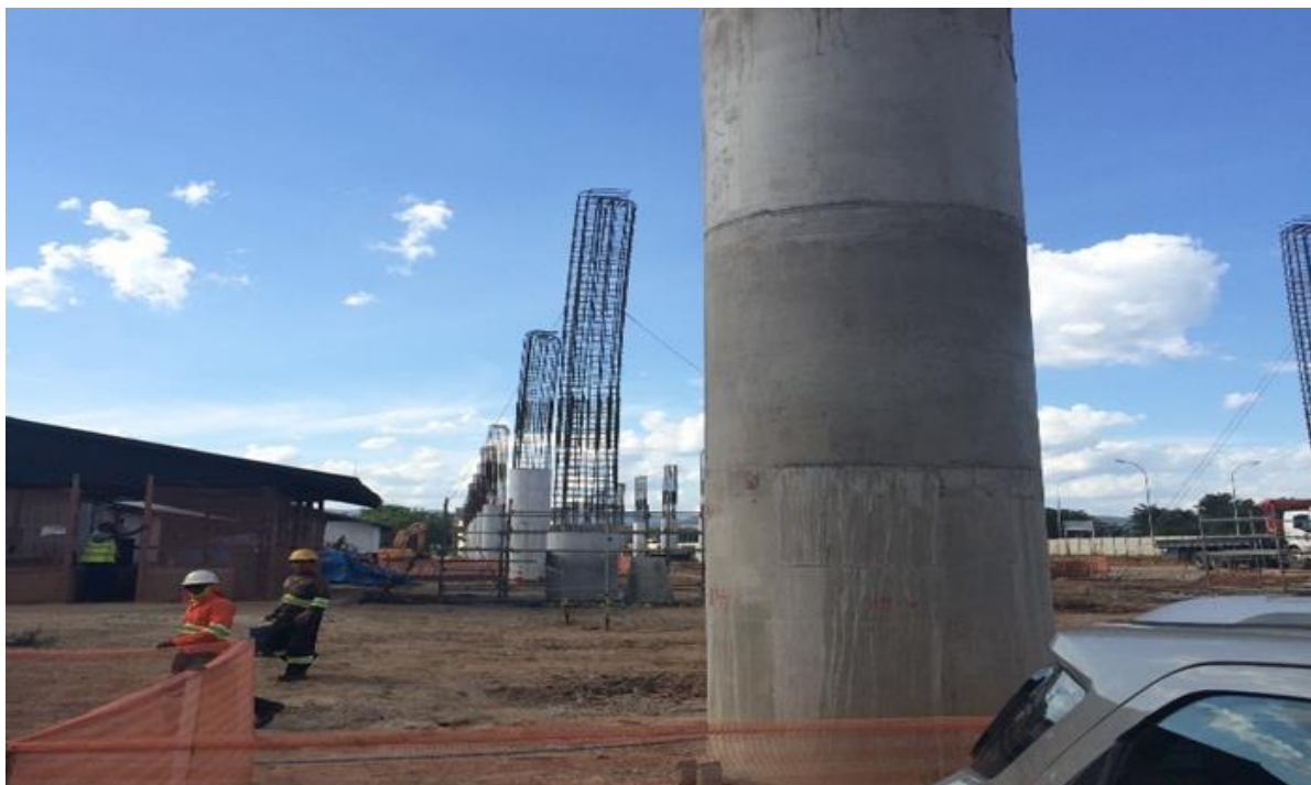
Figura 6.19 – Armação dos pilares no lote 3 (Autor, 2015) 6
