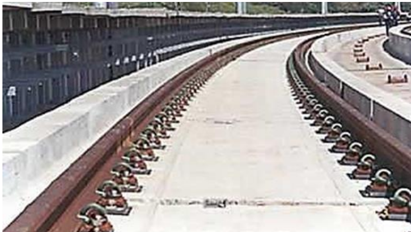
Figura 5.14 - Sistema de superestrutura com fixação direta em viga suporte - Elevado da ligação Capão Redondo - Largo Treze, da CPTM. Disponível em: http://www.acengenharia.com.br/servicos-metros.html . Acesso em: 19 jun. 2015.
