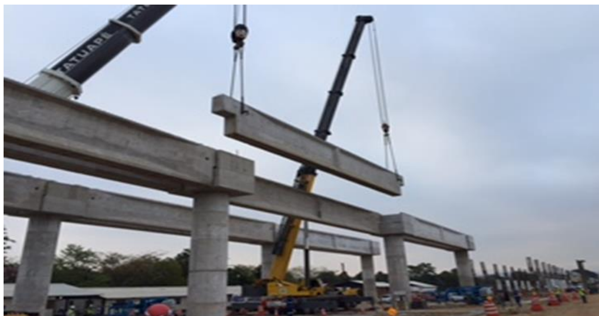
Figura 6.20 – Içamento das vigas por guindastes (CONSÓRCIO HFTS JADE, 2015) 5
